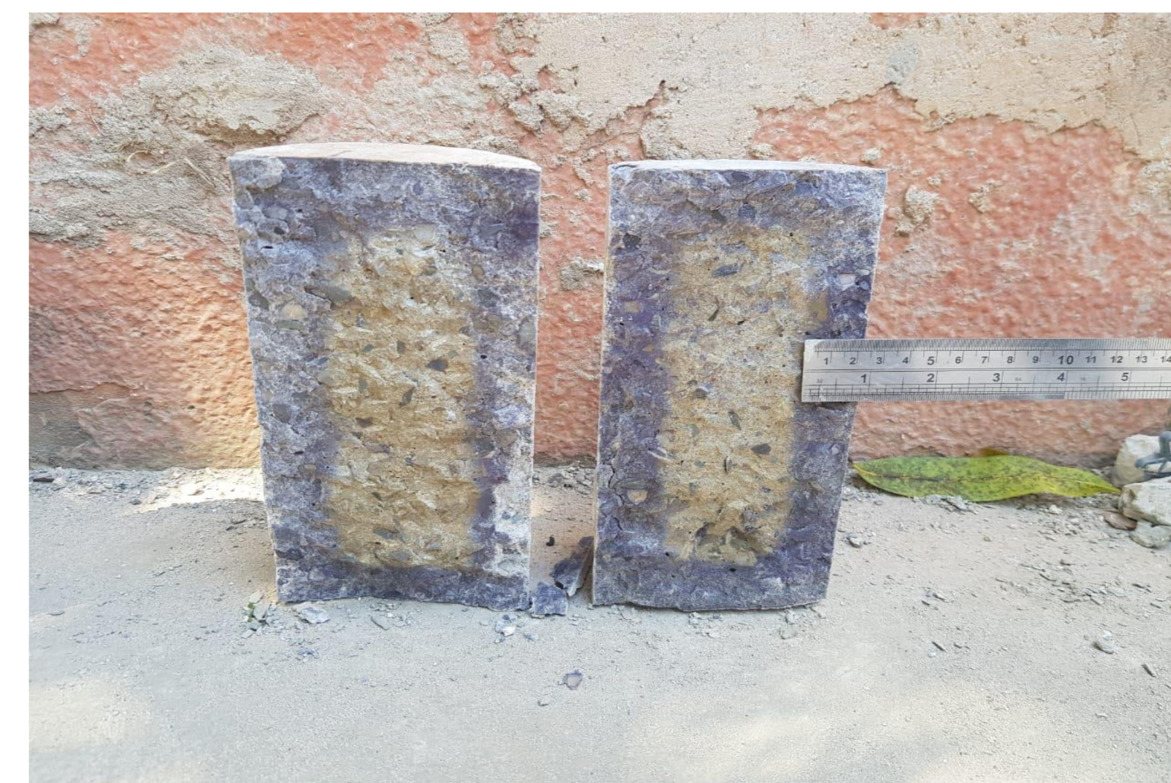
Imagem 2 – Medição da frente de penetração do cloreto
