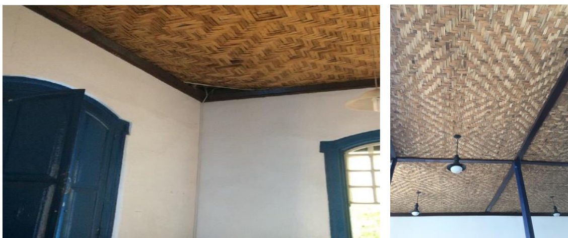
Figura 5 – Substituição de forro de bambu
