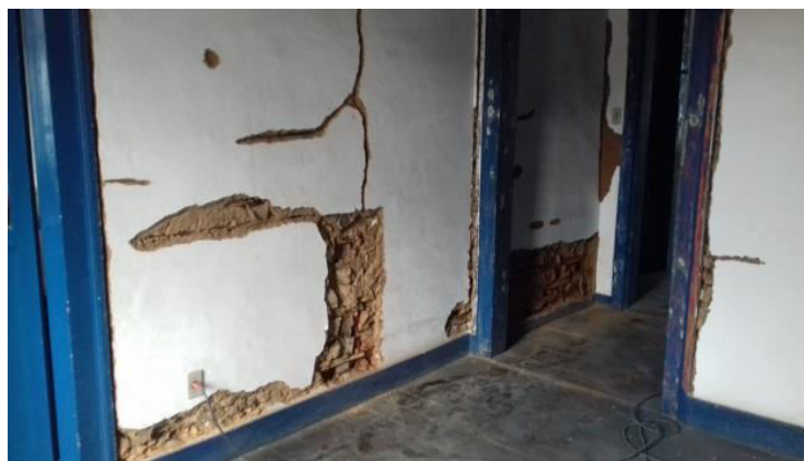
Figura 7 – Alvenaria para vedação
