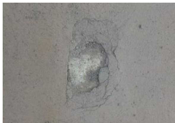
Figura 7 – Afloramento da proteção térmica na região central da placa
