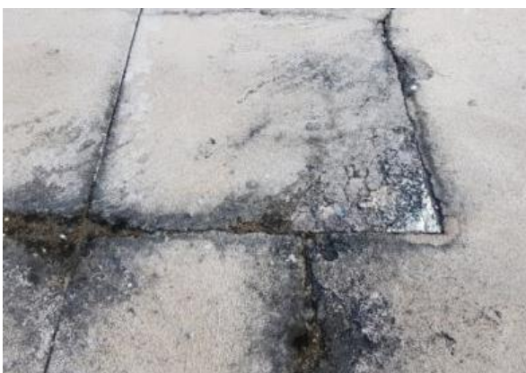
Figura 6 – Afloramento no vértice da placa da proteção térmica
