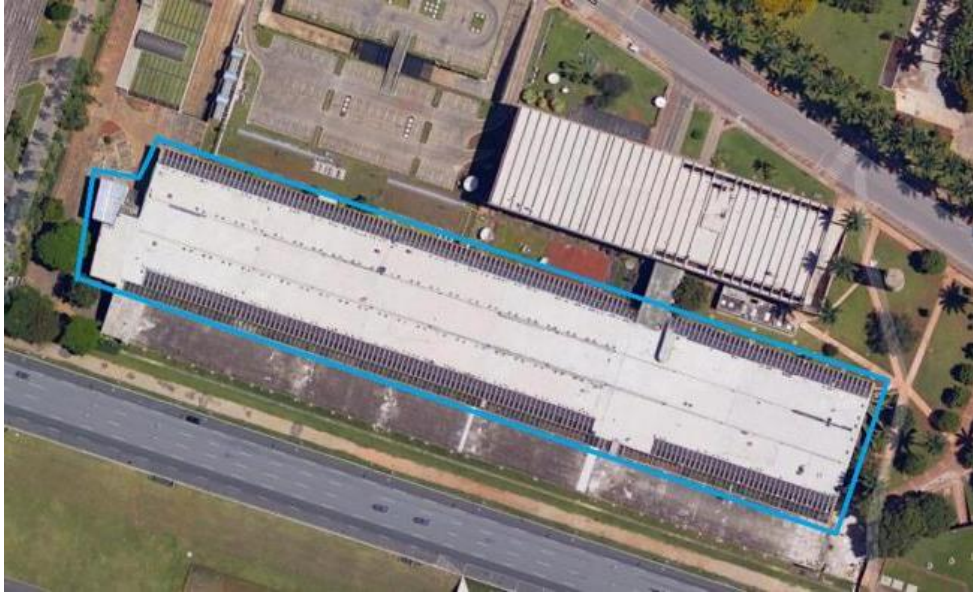
Figura 1 - Laje de cobertura – Edifício Público, Brasília - DF.
