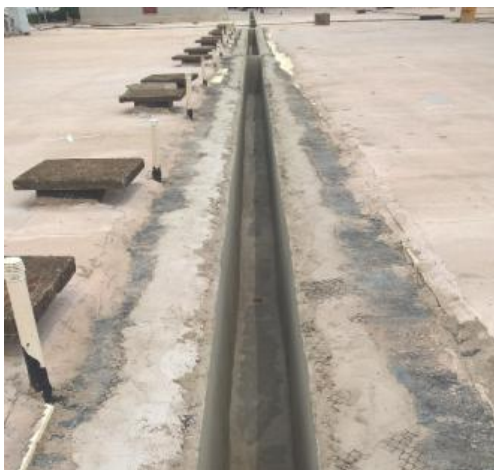
Figura 12 - Proteção térmica e mecânica distante da borda da calha
