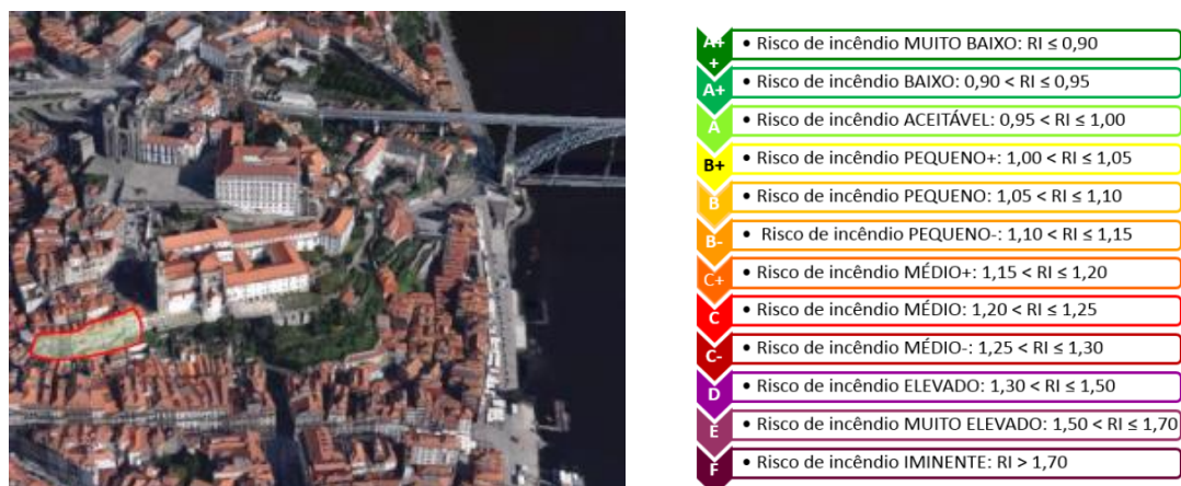
Figura 1 - Centro Histórico do Porto - Quarteirão das Aldas em destaque (esquerda) e escala de classificação de risco de incêndio (direita)
