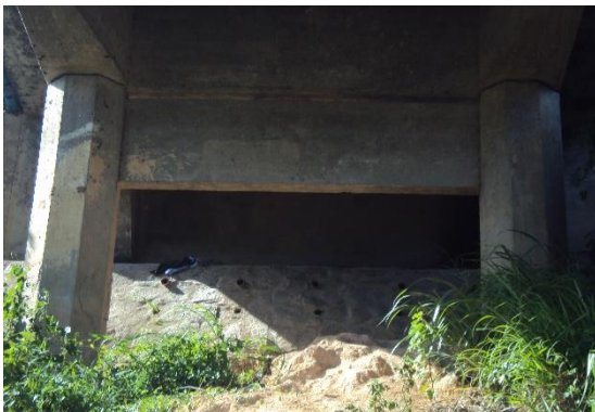
Figura 13 – Pilares localizado nas margens do rio e vista frontal de uma das cortinas da ponte
