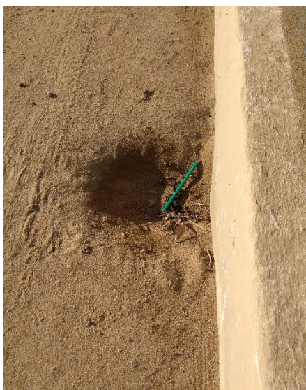
Figura 5 – Dreno obstruído
