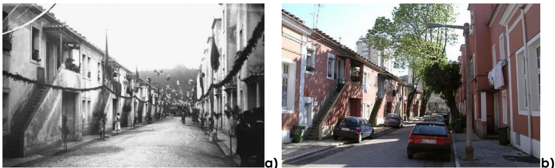
Figura 8 –Vila Grandella / Rua Central: a) lado nascente antes da intervenção; b) lado nascente após a intervenção
