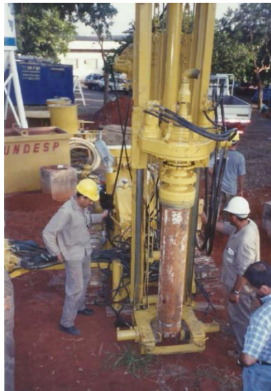
Figura 2 – Perfuração com o tubo de revestimento
