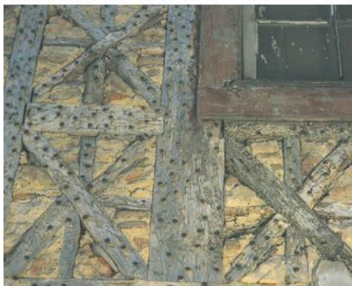
Figura 1 – Parede em taipa de rodízio
