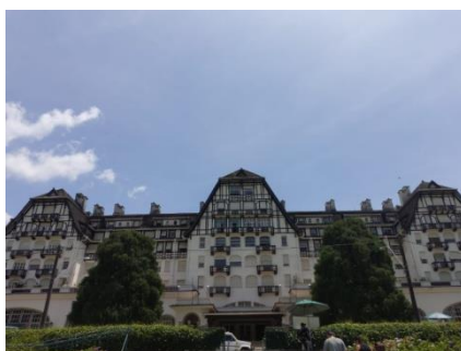
Figura 1 – Condomínio do Edifício Hotel Quitandinha
