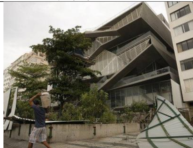
Tapumes danificados em agosto de 2018 Fonte: Portal Extra, 25/08/2018
