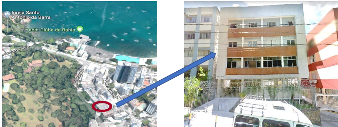
Figura 1 – Imagem da localização e fachada da edificação de estudo
