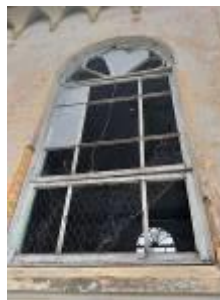
Figura 11 – Esquadrias de madeira
