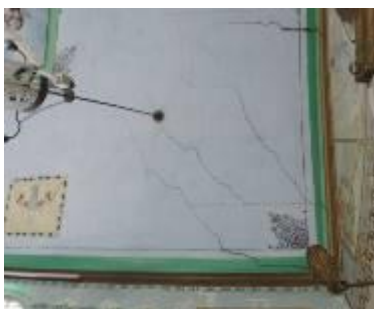
Figura 14 – Forro da nave
