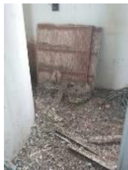
Figura 13 – Piso de cimento queimado
