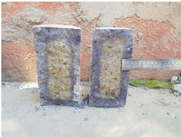
Imagem 7 – Medição da frente de penetração do cloreto
