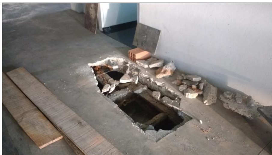
Figura 1 – Janela de inspeção na caixa de gordura localizada no estacionamento
