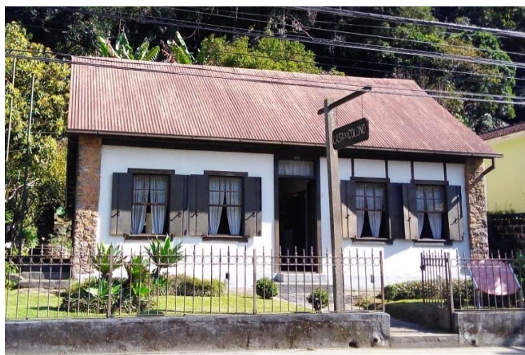
Figura 1 – Fachada da Casa do Colono
