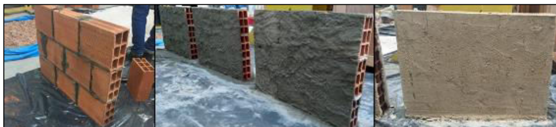
Figura 3 – Confeção dos painéis de alvenaria
