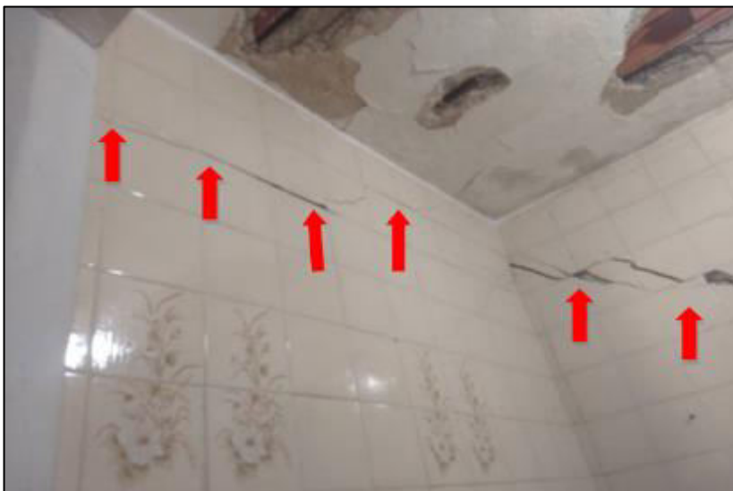
Figura 13 – Rachaduras horizontais
