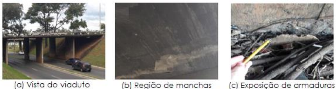
Figura 1 – Viaduto localizado na Via L4 Sul, em Brasília (DF).
