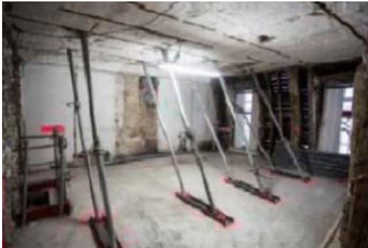
a) Pisos metálicos
