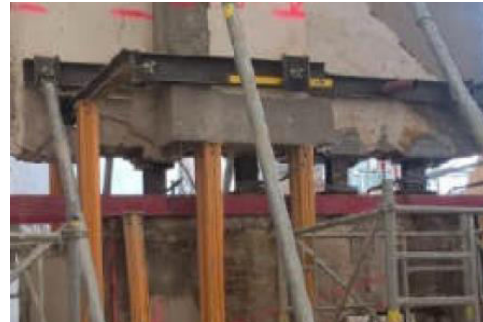
b) Cofragem da viga
