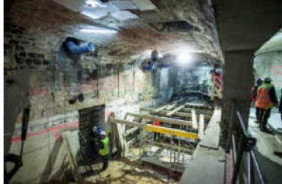
b) Paredes da cave
