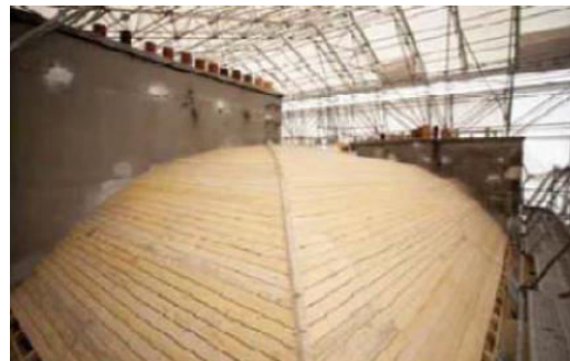
b) Nova cobertura
